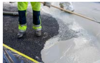
MICROFOND – Mortier liquide haute performance pour revêtements semi-rigides percolés. Réalisation de plateformes et de zones de circulation à haute résistance au poinçonnement et à l'ornièrage. (KARP-KNEIP, Transition tram/bus bd Royal, Luxembourg)
