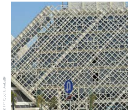
NANODUR Compound 5941 – Liant prêt à l'emploi pour la réalisation d'éléments en béton fibré autoplaçant haute à ultra-haute performance. Utilisé pour la réalisation de bâtis de machines-outils dans de nombreux domaines ainsi que pour la réalisation d'éléments préfabriqués architecturaux. Exemples : machine-outil robotisée, habillage de façade en résille BFUP MANATEQ HEADQUARTER, Doha, Qatar
