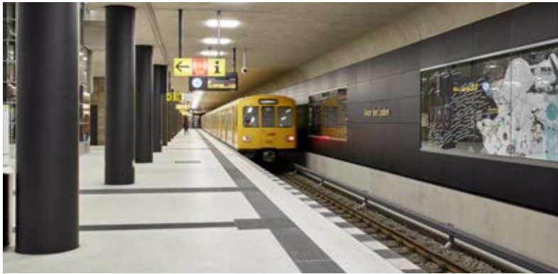
TERRAPLAN – Dalle de béton poli type terrazzo (Gare souterraine Unter den Linden, Berlin)
