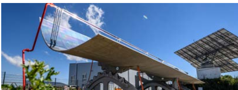
Concentrateur solaire parabolique orientable de 12 x 6 m. La parabole, les supports ainsi que les pièces mécaniques d'orientation sont réalisés en BFUP (TU KAISERSLAUTERN, DESERTEC)
