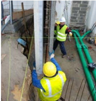
ENDOVAC – prémurs à isolation sous vide VIP intégrée (BÉTONS FEIDT)
