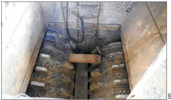
Concasseur primaire Arbed en cours de maintenance.
