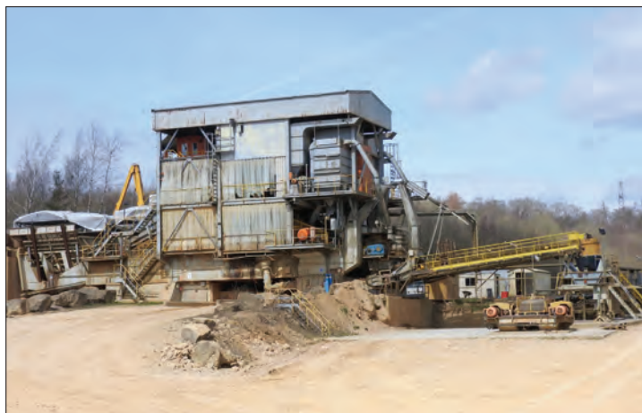
Poste de concassage primaire.
